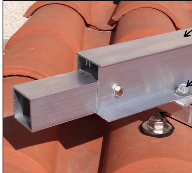
Imagen 10: Fijación P-26A sobre teja
