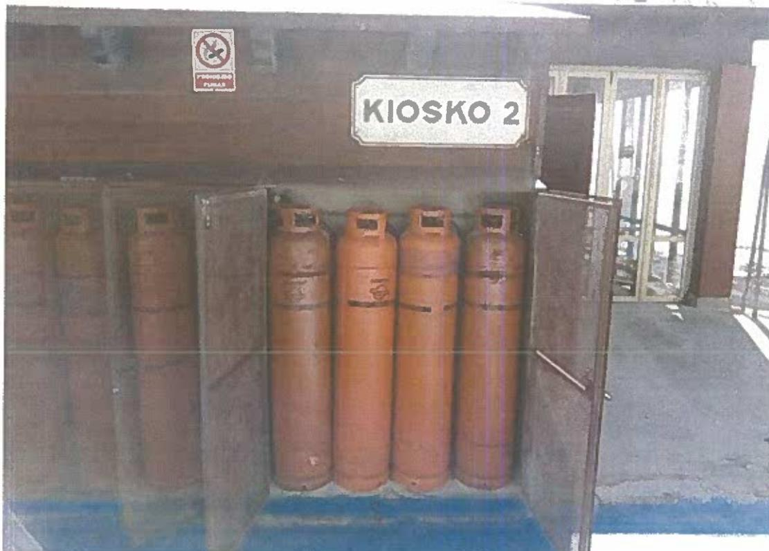
**Caseta de los depósitos móviles de GLP con oxido y sin mantenimiento.**
