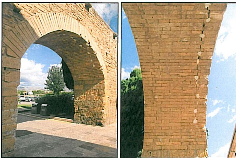
Imatge general de la porta de San Sebastià i de l'esquerda amb els testimonis.
