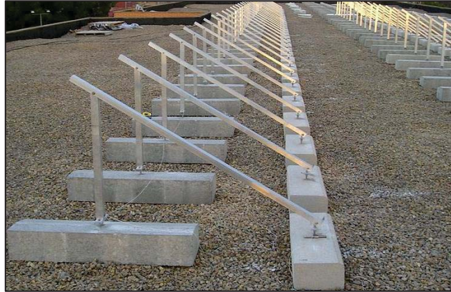
Imagen 21: Ejemplo bastidor sobre bordillos de hormigón
