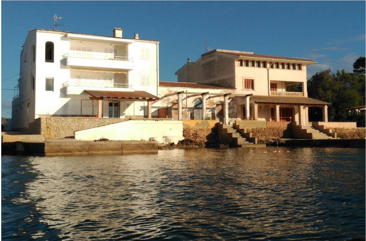
Imagen 4. Primer tramo, con la edificación objeto a aumentar altura en la parte central.
