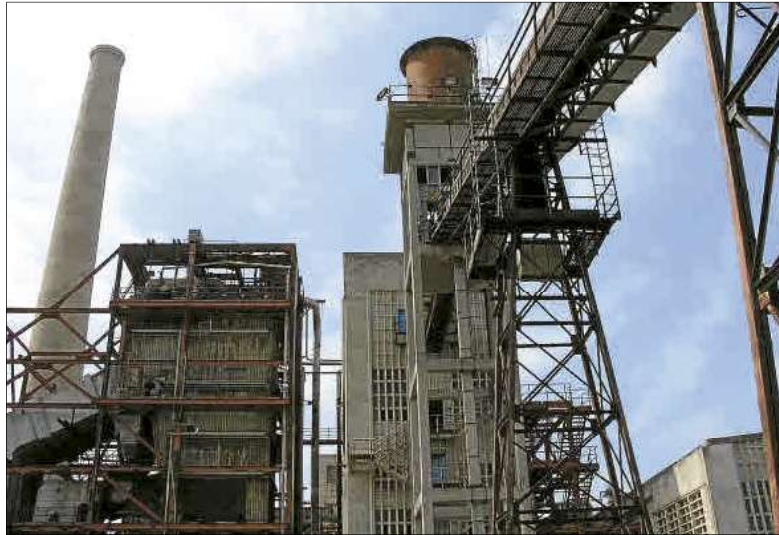
Medalla de Oro de la Arquitectura. La vieja central de Alcanada fue construida entre 1955 y 1961 siguiendo un proyecto del arquitecto Ramón Vázquez Molezún (Medalla de oro de Arquitectura en 1992). Tenía una vida útil de 23 años prorrogables hasta un máximo de 50. Está en desuso desde 1980.
