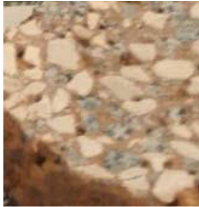
Imagen 1. Acabado del pavimento
