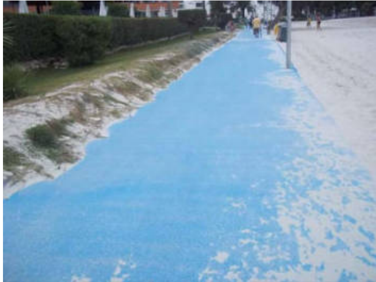
Foto 1. Paseo peatonal acondicionado sector I
