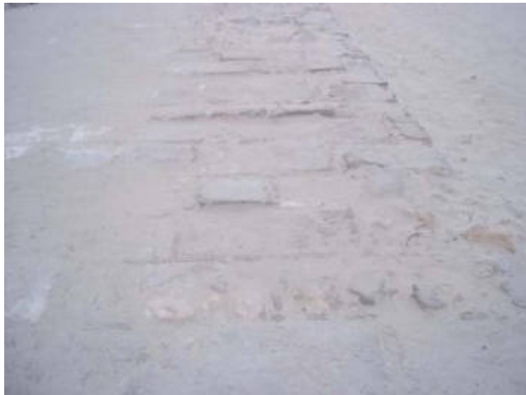
Foto 2. Paseo peatonal existente tramo II
