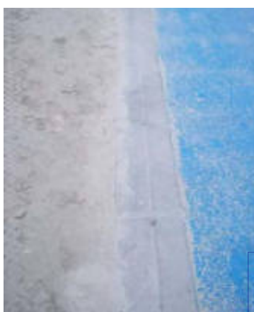
Foto 3. Bordillo enrasado existente en el tramo I
