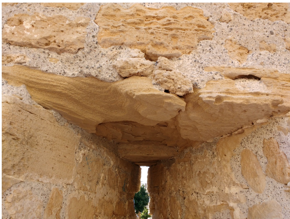
Detall de la sagetera amb la llosa del llinda greument erosionada alveolarment per acció del vent conduit en forma d'embut per l'obertura de la mateixa.
