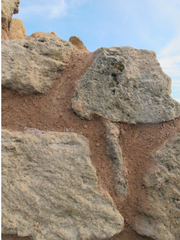
1. Detall d'aplicació de tessel·les adherides per separar visualment l'original i l'afegit
