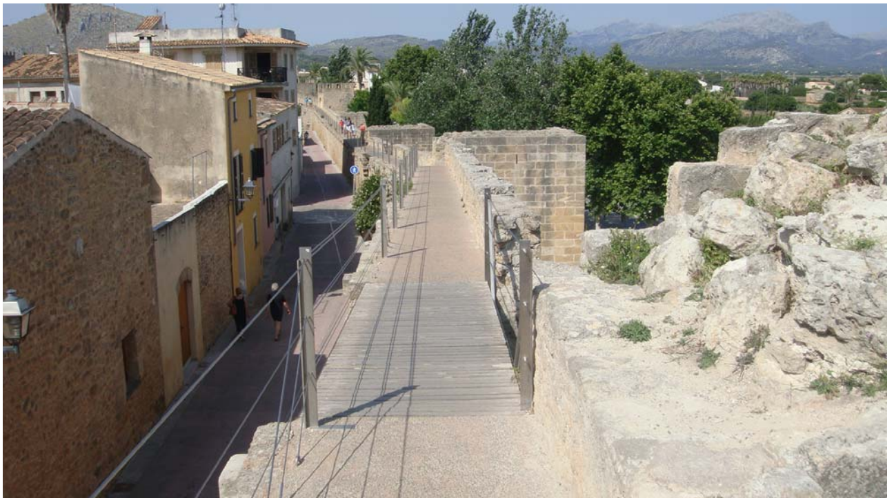
Fotografia 7.- Vista de conjunt d'un tram ja executat.
