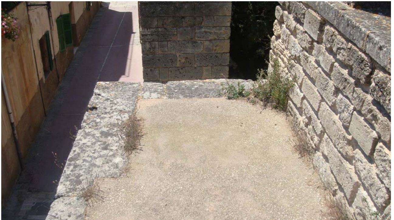
Fotografia 6.- Detall del final del tram pavimentat.
