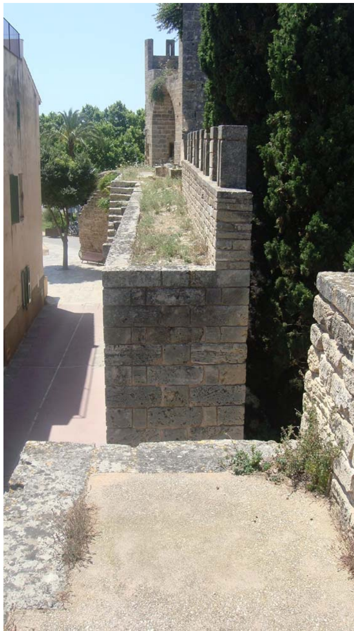
Fotografia 3.- Vista de conjunt del tram a executar.
