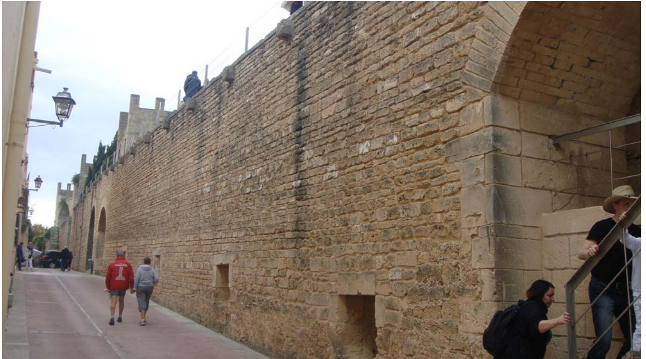
Fotografia 18.- Vista interior d'una secció del tramo oest a rehabilitar
