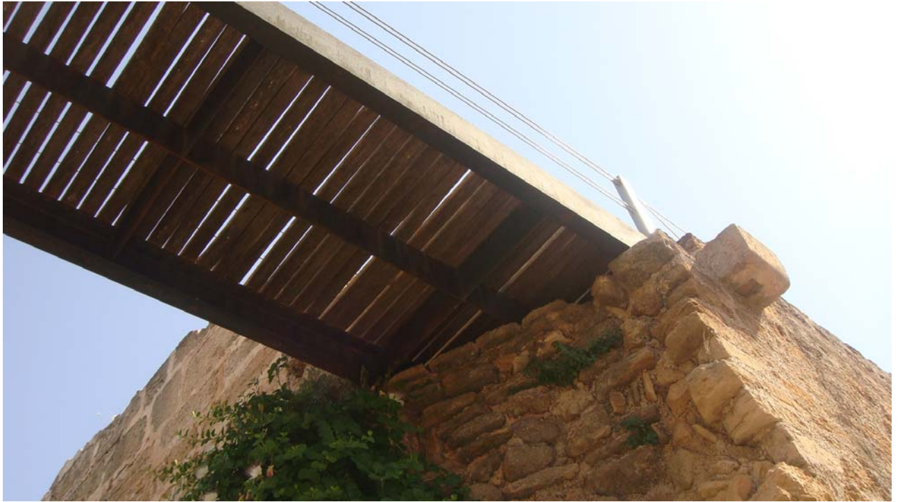
Fotografia 8.- Vista inferior d'una de les passarel·les ja executades.
