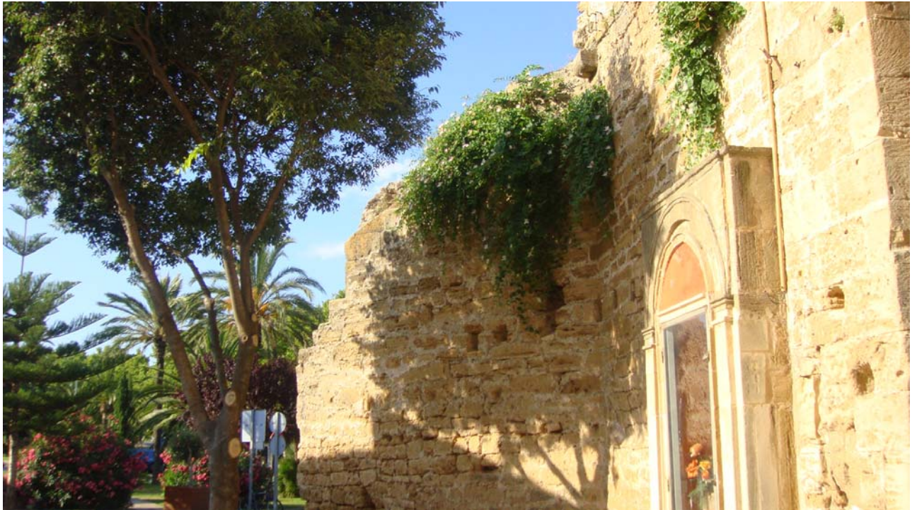
Fotografia 22.- Vista interior d'una secció de la Porta de Sant Sebastià
