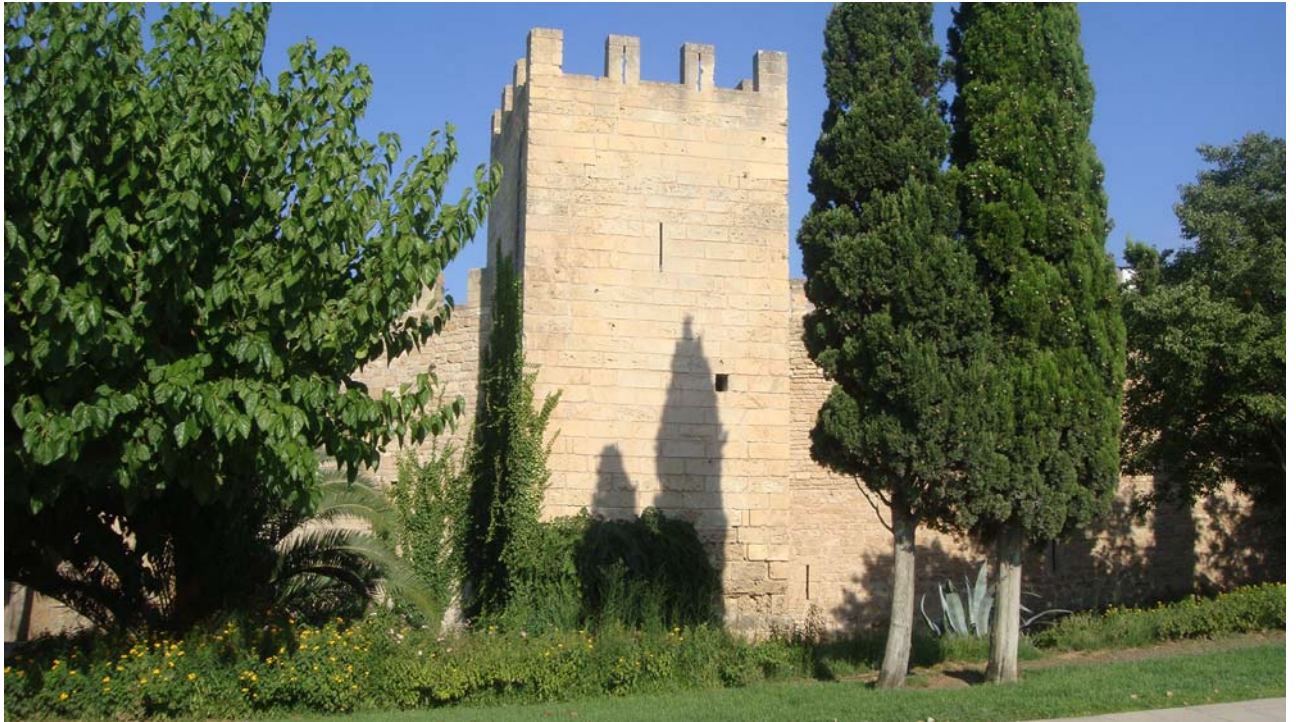
Fotografia 14.- Vista exterior d'una altra secció del tramo oest a rehabilitar
