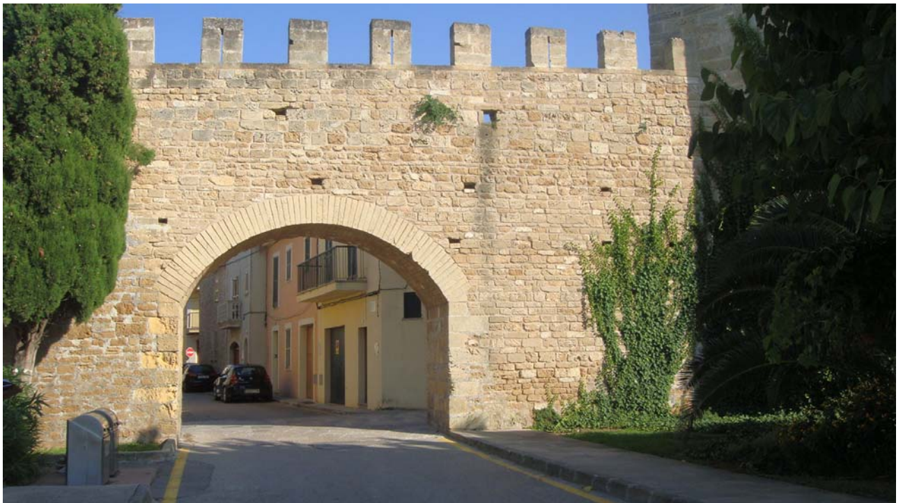
Fotografia 15.- Vista exterior d'una altra secció del tramo oest a rehabilitar
