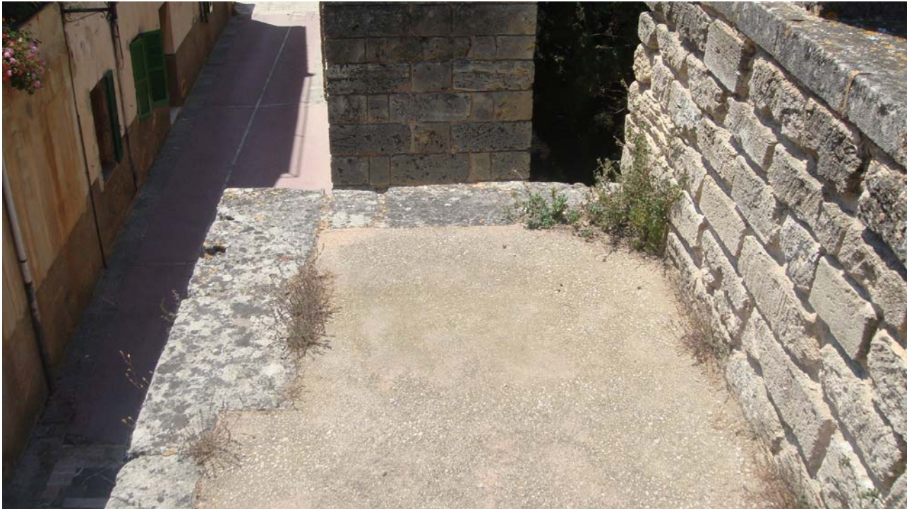
Fotografia 6.- Detall del final del tram pavimentat.
