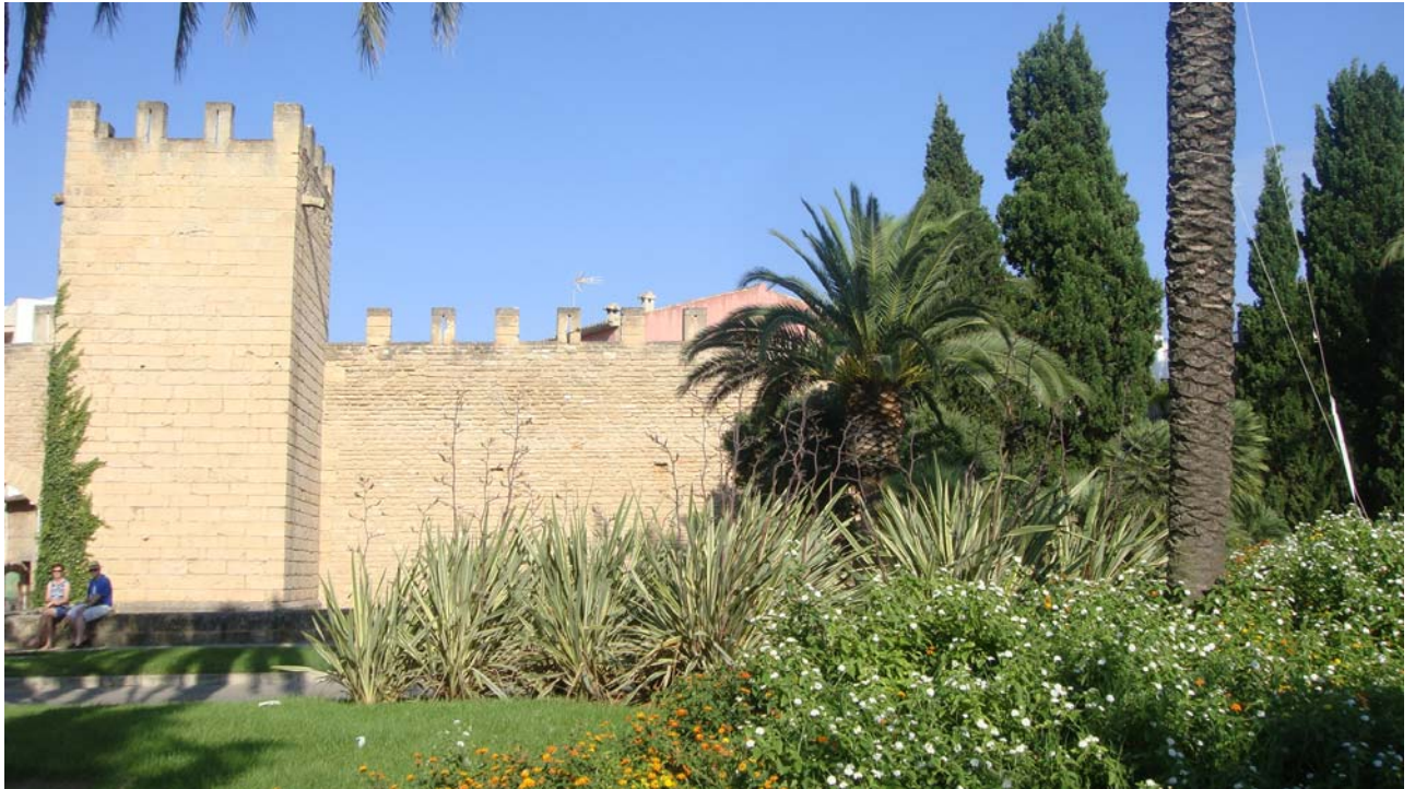
Fotografia 12.- Vista exterior d'una altra secció del tramo oest a rehabilitar
