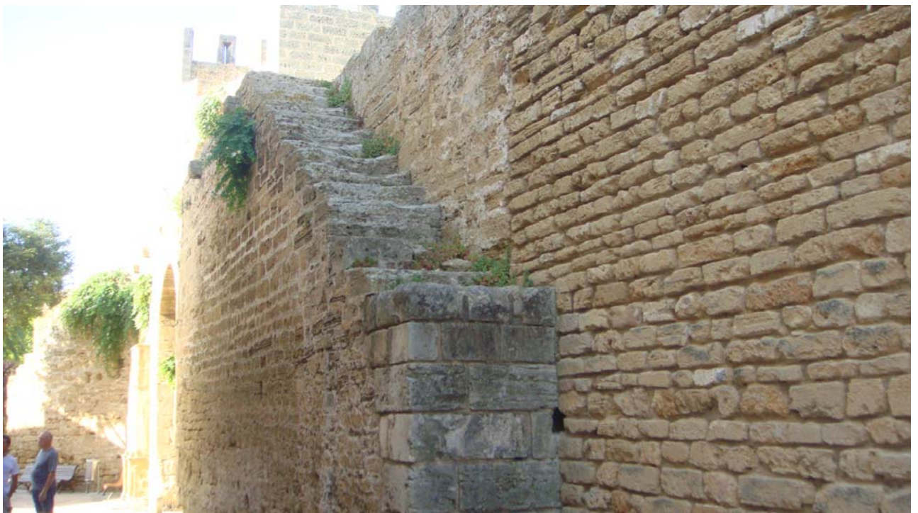
Fotografia 21.- Vista interior d'una altra secció del tramo oest a rehabilitar
