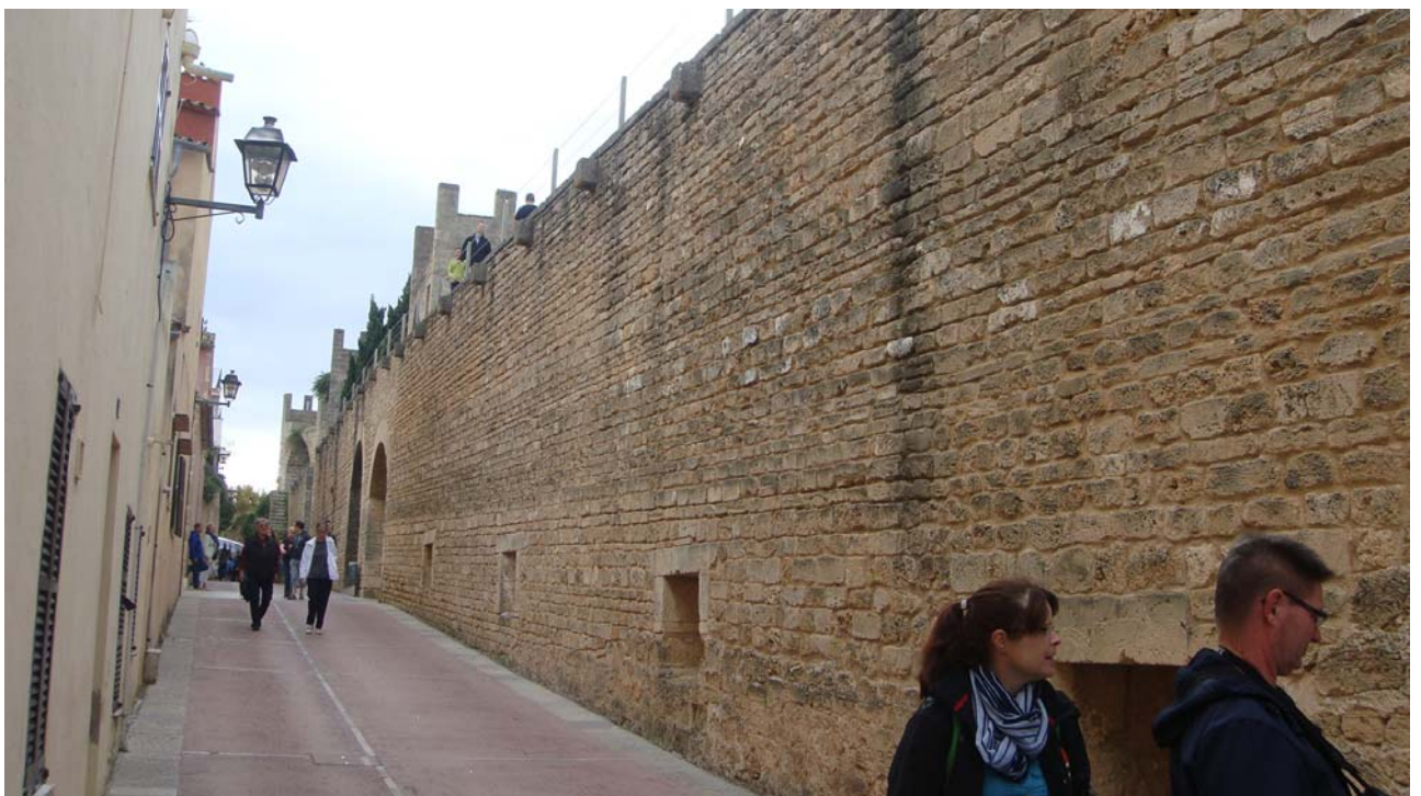
Fotografia 19.- Vista interior d'una secció del tramo oest a rehabilitar
