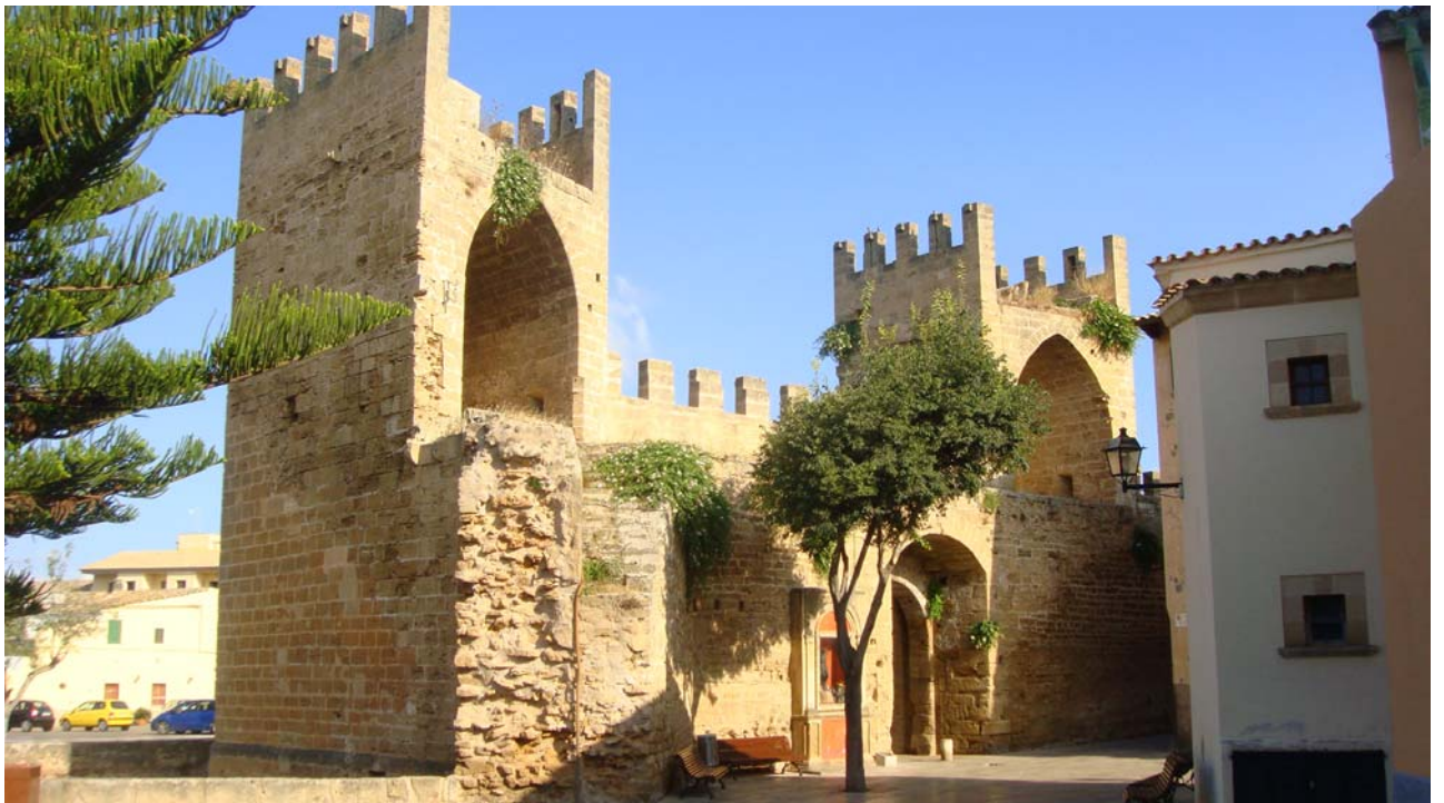
Fotografia 2.- Vista de la Porta de Sant Sebastià des de l'interior de les murades
