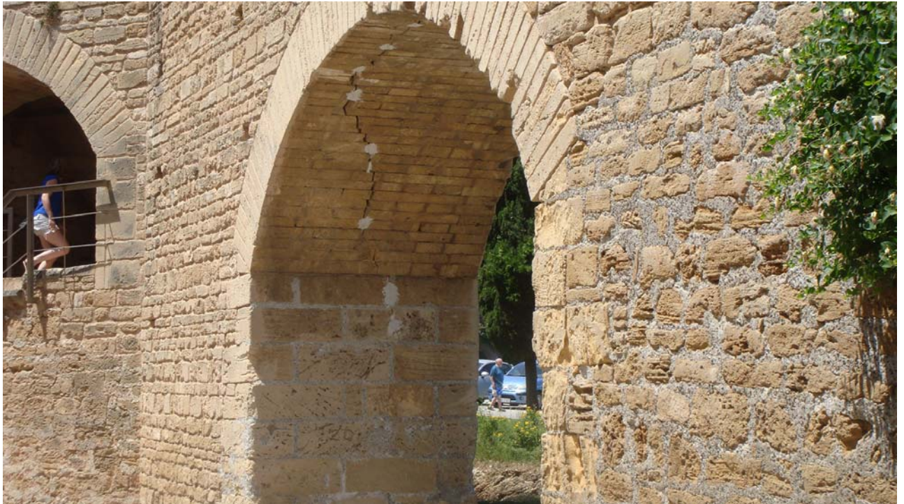
Fotografia 16.- L'arc que marca el final del tramo nord
