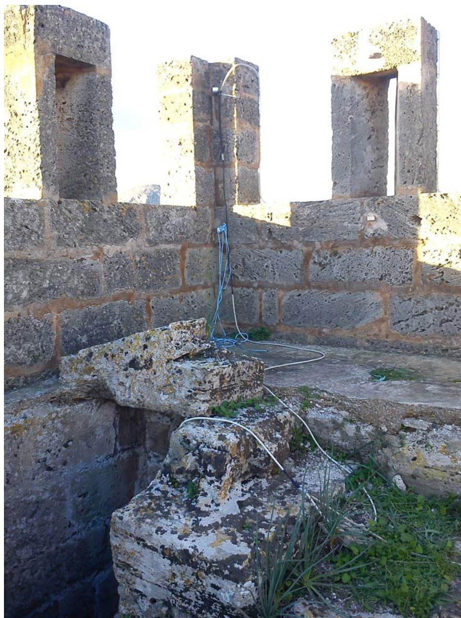
Fotografia 5.- Vista de la part superior de la torre
