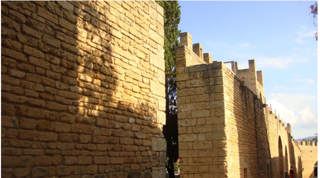
Fotografia 20.- Vista interior d'una altra secció del tramo oest a rehabilitar
