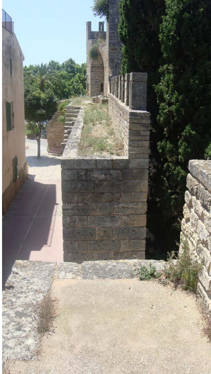
Fotografia 3.- Vista de conjunt del tram a executar.
