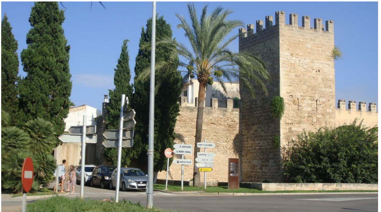
Fotografia 11.- Vista exterior de conjunt de part del tram a executar.
