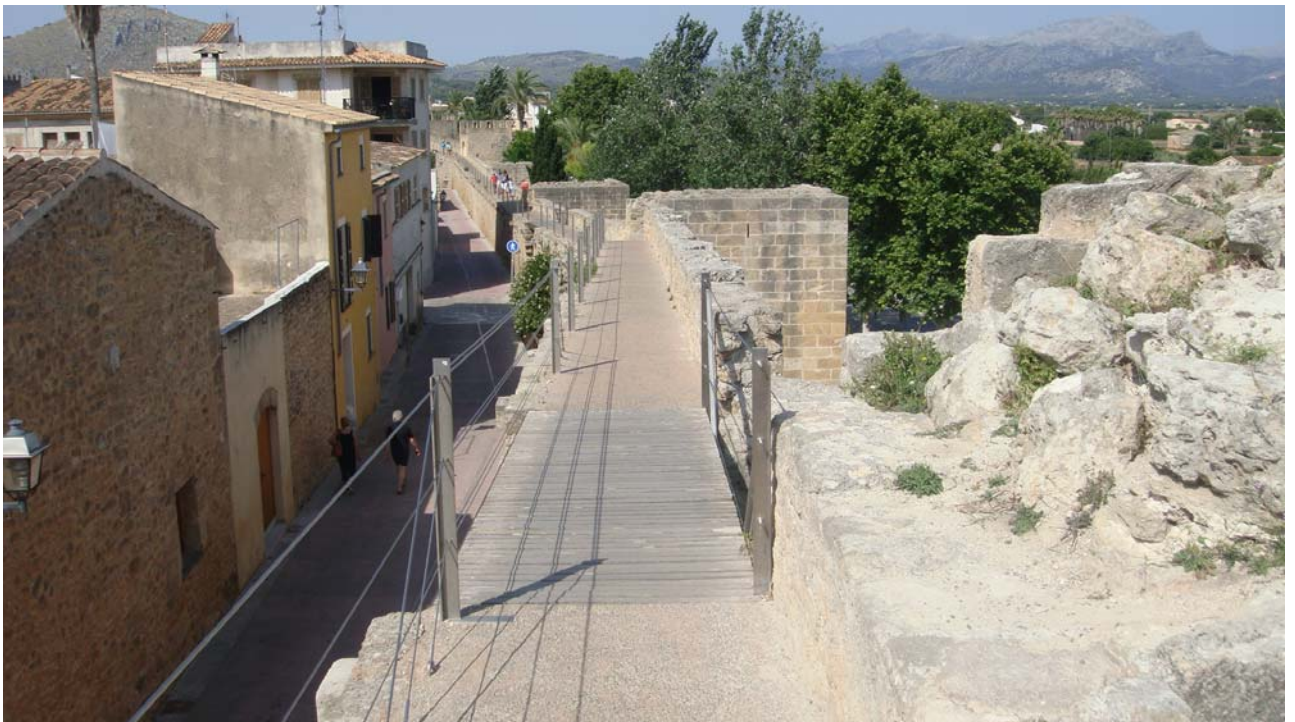
Fotografia 7.- Vista de conjunt d'un tram ja executat.
