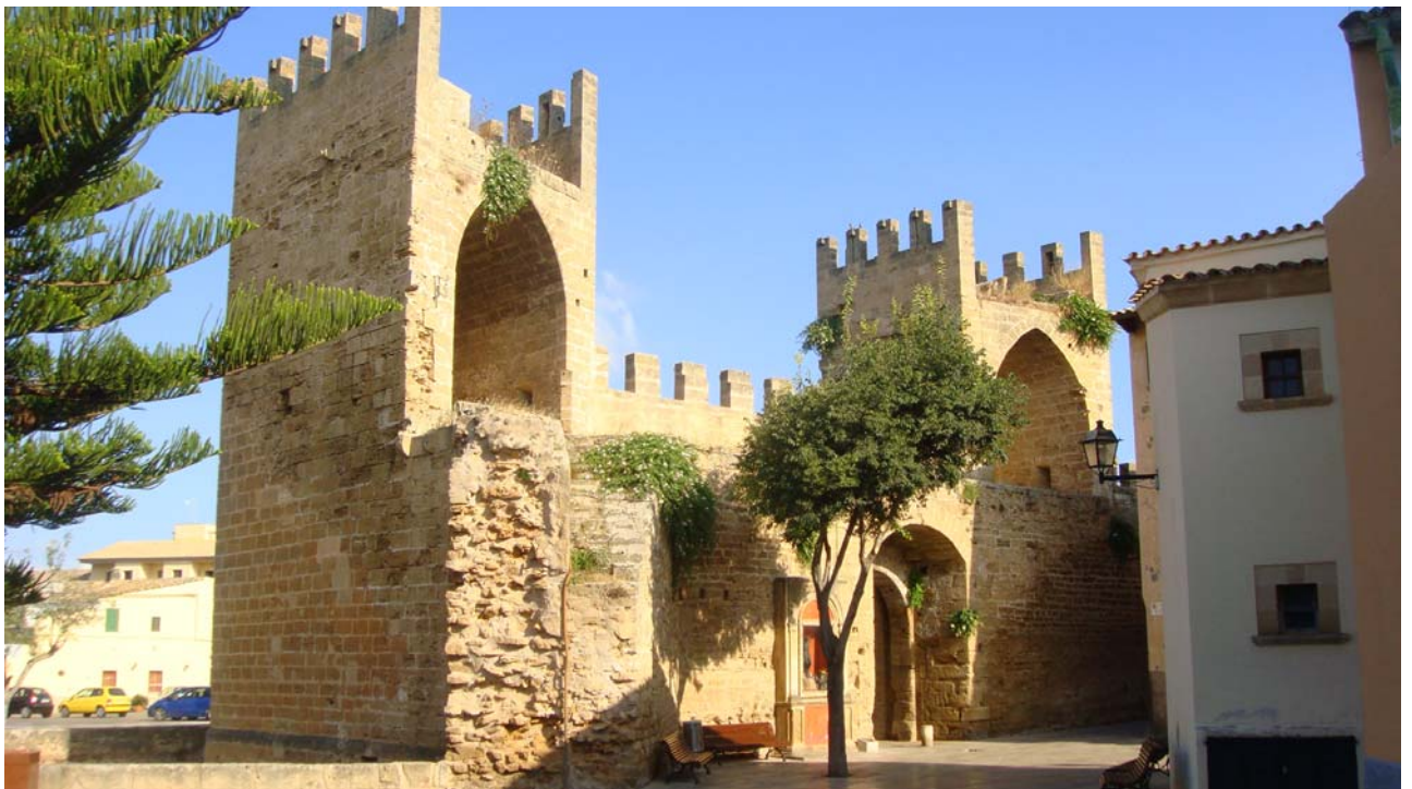
Fotografia 23.- Vista interior d'una altra secció de la Porta de Sant Sebastià
