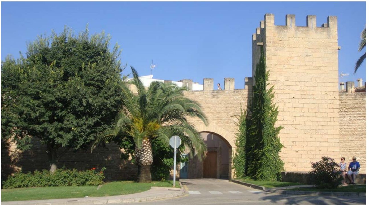
Fotografia 13.- Vista exterior d'una altra secció del tramo oest a rehabilitar
