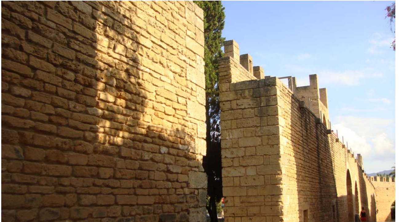
Fotografia 1.- Vista del final del tram per als vianants executat
