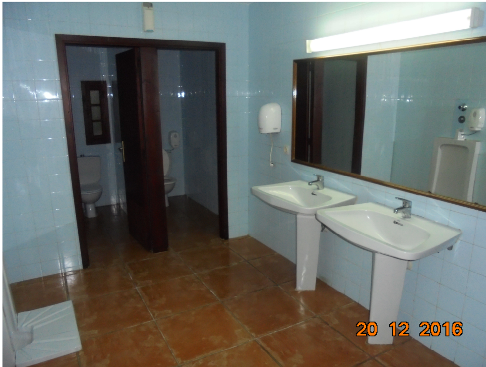
Imagen 03 – Baño hombres existente.
