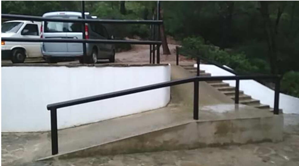
Imagen 01 – El acceso actual no cumple con el D110/10 de supresión de barreras arquitectónicas.
