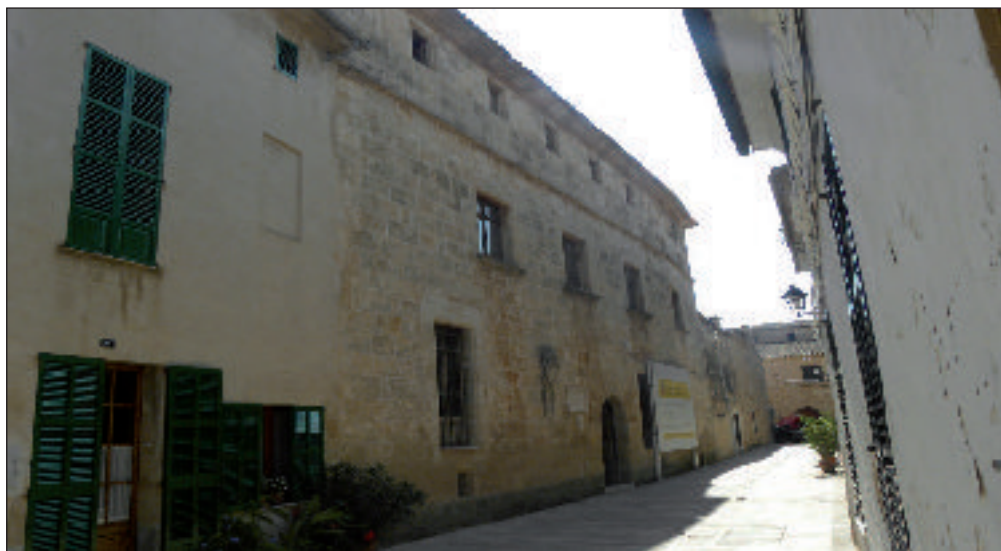
Figura 2. Façana del casal principal al carrer dels Albellons.
