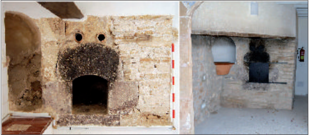
Figura 13. El forn al moment del seu descobriment (esquerre) i un cop recuperada la seva funcionalitat (dreta).
