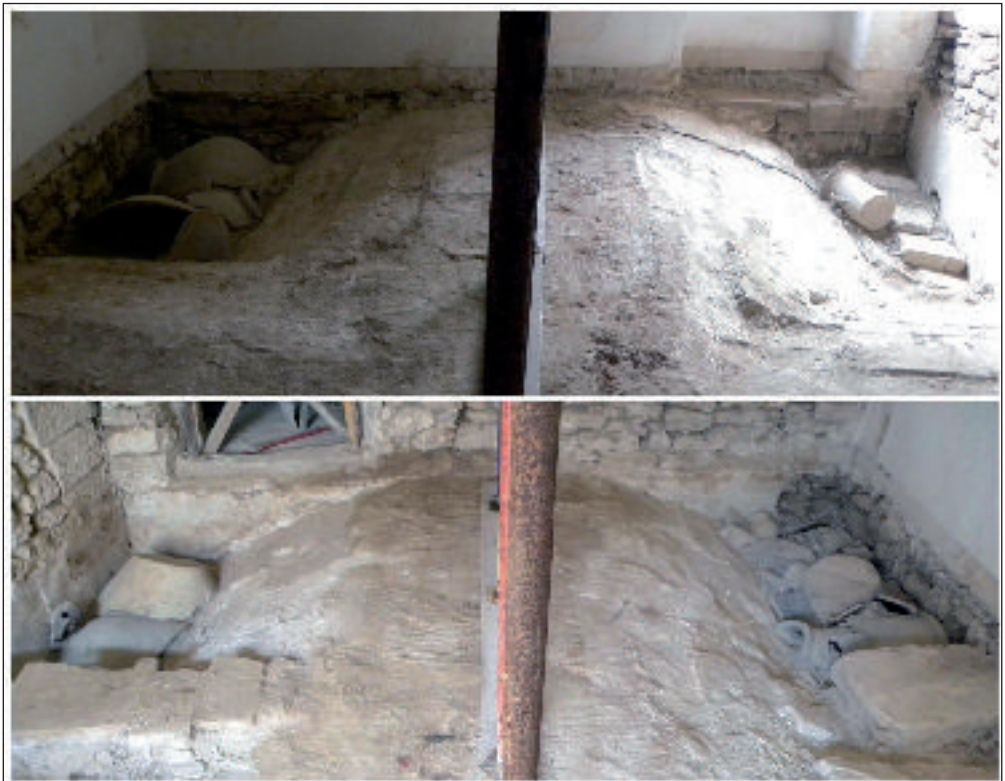
Figura 14. Els quatre cantons de la volta d'aresta amb els materials documentats in situ.
