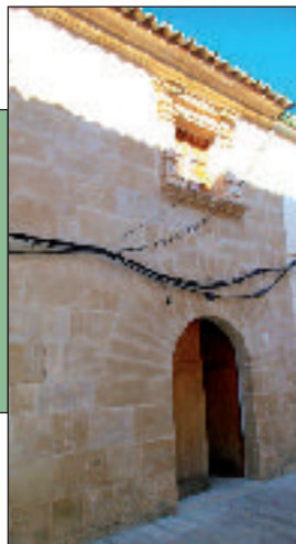
Il·lustració 22: Calle de la Roca nº12. Façana gòtica en fase B amb ventana renaixentista.
