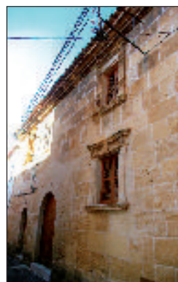
Il·lustració 32: Calle de la Parra n° 7, edifici del tipo F.
