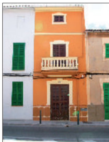
Il·lustració 24: AV. Inca nº43. Edifici del tipus gòtic en la seva fase C, construït en el segle XX.
