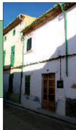
Il·lustració 28: Calle Sant Jaume nº11 edifici en la fase E del tipus gòtic.
