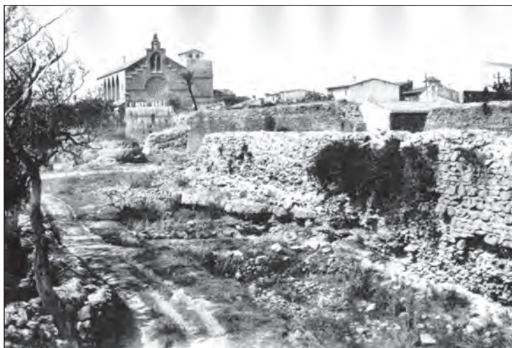
Figura 1. Fotografia de principis de segle XX de la zona afectada per l'obra, amb la murada renaixentista força malmesa però encara en peu i la murada medieval en segon terme. A la dreta s'intueix l'entrada al carrer d'en Serra. Font: Arxiu Municipal d'Alcúdia.
