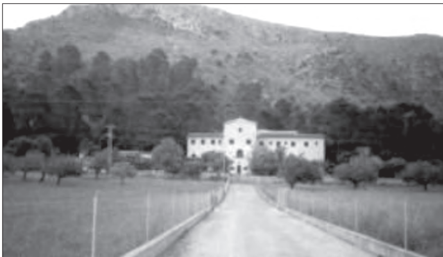
Edifici actual de Son Fe.
